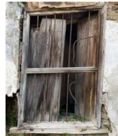
Παράθυρο με κάθετα τοποθετημένα σίδερα. Λόγω αυτού, οι σανίδες ανοίγουν προς τα μέσα.
