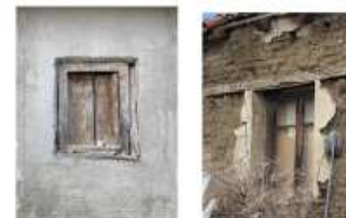
Παράθυρο με κάθετα τοποθετημένα σίδερα. Λόγω αυτού, οι σανίδες ανοίγουν προς τα μέσα.
