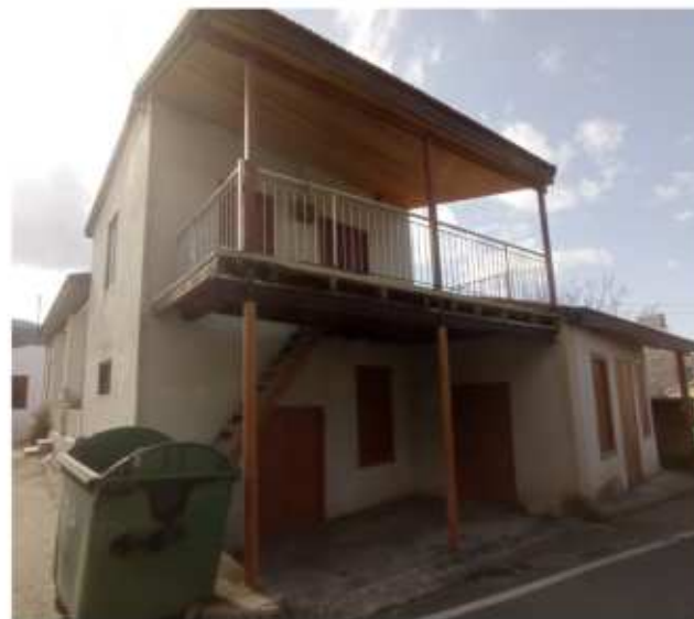
ΔΗΜΙΟΥΡΓΙΑ ΣΤΕΓΑΣΤΡΟΥ ΜΕ ΟΡΘΗ ΓΩΝΕΙΑ - ΞΕΧΩΡΙΣΤΗ ΚΑΤΑΣΚΕΥΗ
