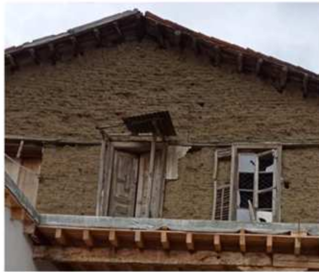
Παντζούρια: το συγκεκριμένο είδος παραθυρόφυλλου με τις οριζόντιες ράγες χρησιμοποιείται σε αρκετές περιπτώσεις στο χωριό.
