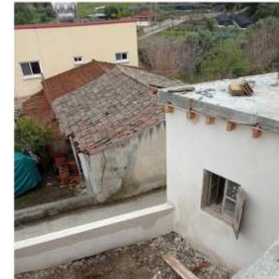
Τα σανίδια ανοίγουν προς α έξω ενώ το τζάμι προς τα μέσα.
